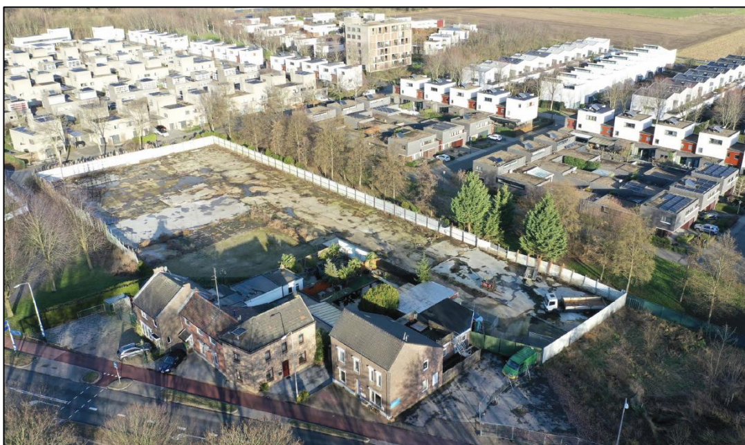
Noordelijke gedeelte van het plangebied in de huidige situatie | bron: CB5 Architectuur & Stedenbouw
